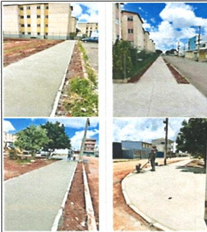
8508-0063 - Aquisição de Meio fios pré-moldados de concreto para a recuperação de vias
